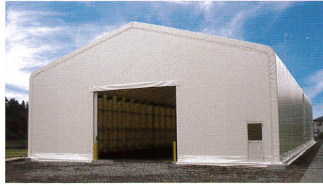
施工例：テント倉庫
