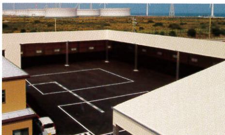
施工例：工場荷捌き場
