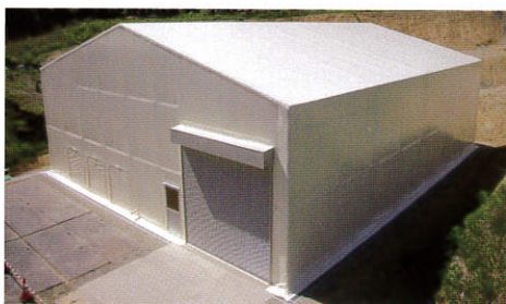
施工例：テント倉庫
