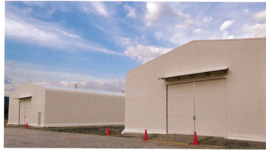
施工例：テント倉庫
